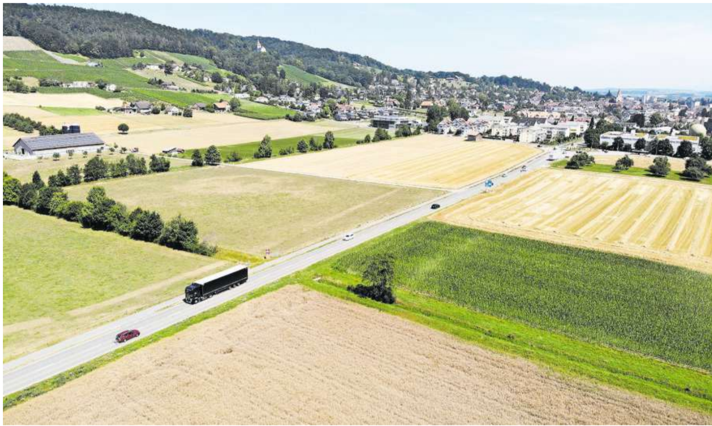
Der Bund will die BTS-Strecke «umfassend überprüfen»: Blick auf den Abschnitt westlich von Weinfelden.
