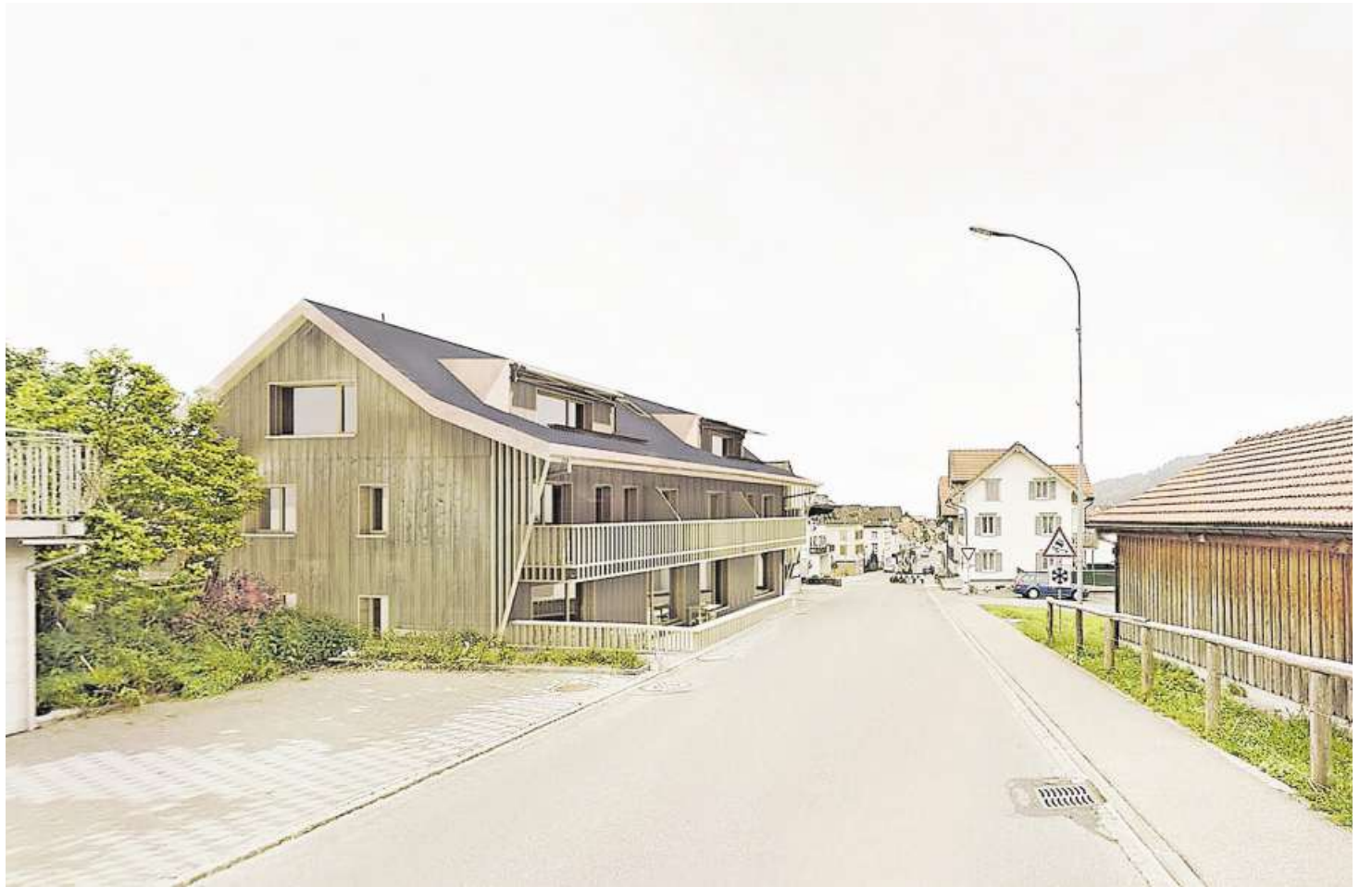
Der Anbau der Liegenschaft «Drei König» in Oberegg wurde abgerissen. Dort entsteht ein Neubau.
