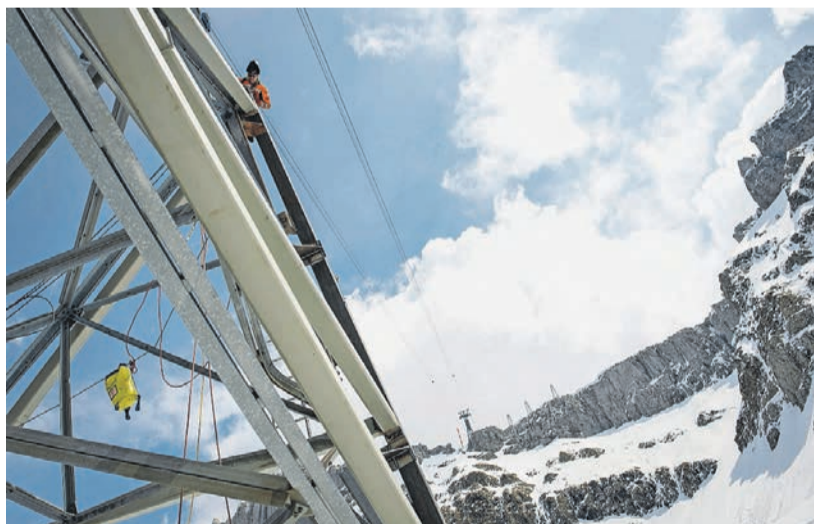
Lawinen. Aufwendige Reparaturarbeiten an der beschädigten Stütze. FOTO KEYSTONE
