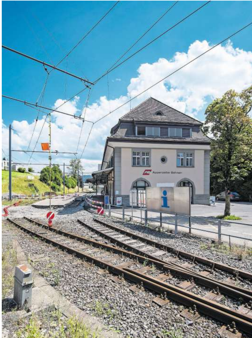
Der Baustart am Bahnhof Teufen ist auf Juni angesetzt. Bild: Benjamin Manser
