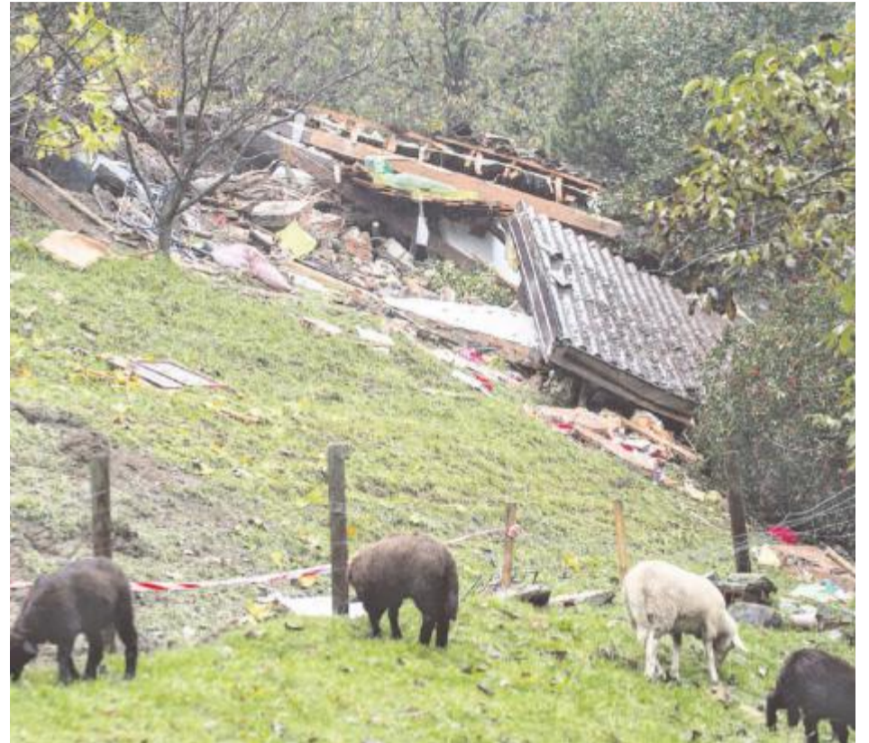
Erdbeben. Rund 100 Kubikmeter Erde gerieten ins Rutschen und zerstörten das umgebaute Rustico.
