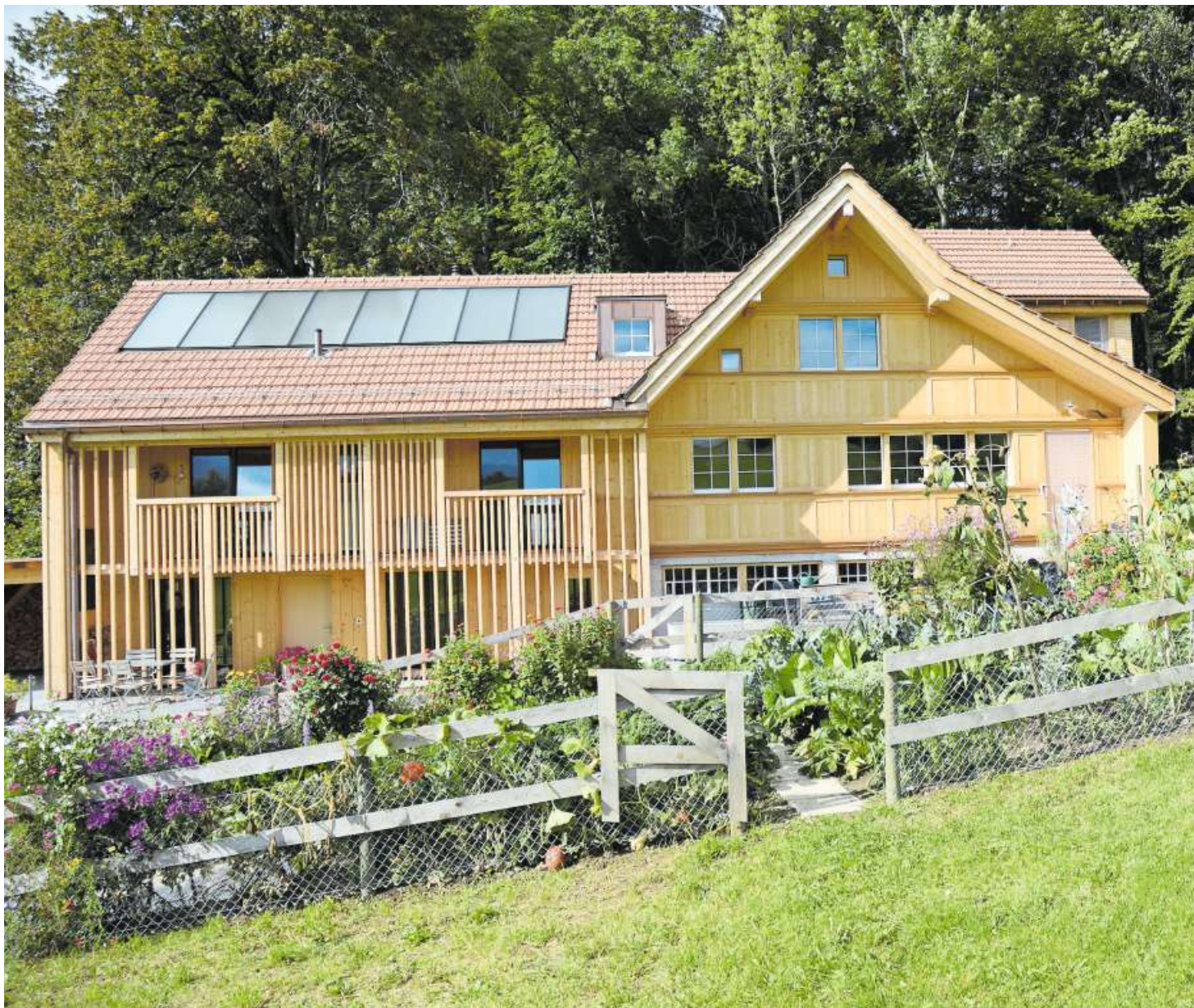
Das Haus von Ruedi Lanker in Niederteufen ist ein gutes Beispiel für eine nachhaltige Sanierung.
