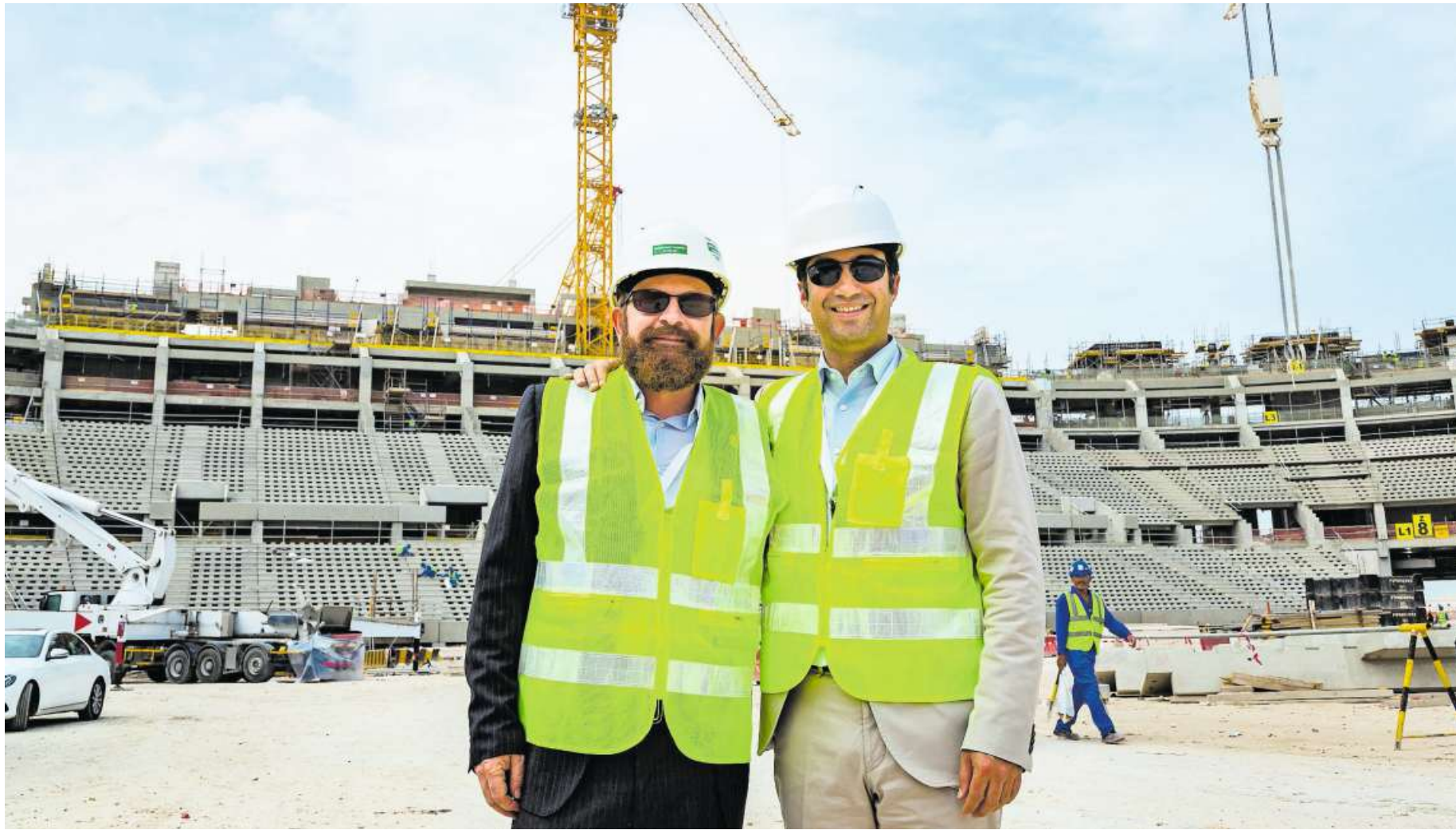
2022 rollt hier der Ball: Andrea Caroni (rechts) lässt sich vom Projektleiter die Baustelle eines WM-Stadions zeigen.
