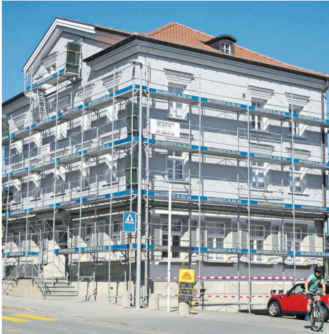
Am geschichtlich interessanten Gemeindehaus werden Renovationsarbeiten durchgeführt.
