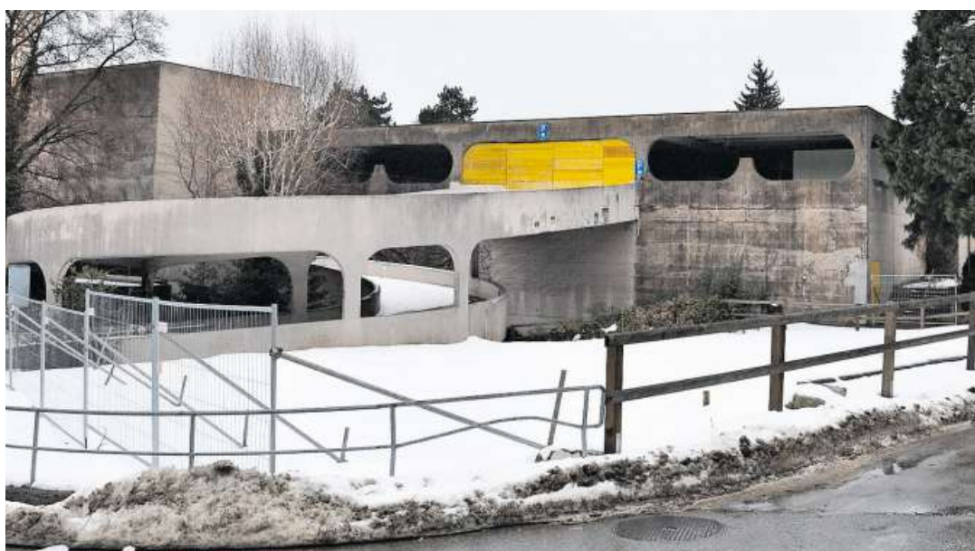
Grau in grau, nur die Bretterverschläge sorgen noch für einen Farbtupfer.
